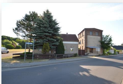
Straßenfrontansicht Mühlengebäudes, links angrenzendes Hofgrundstück (eigenes Flurstück)
