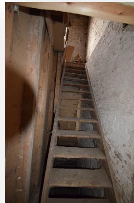
seitlich angelagerte Treppenanlage einfachster Bauart über alle Geschosse
